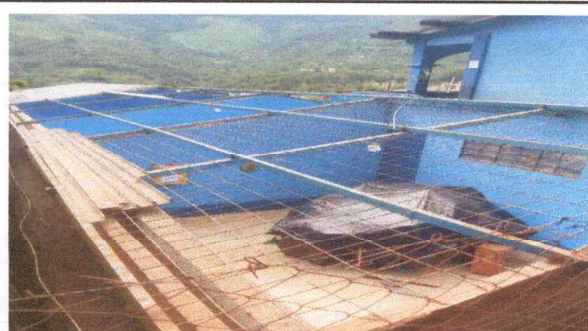
Foto 2: EN ESTA PARTE SE INICIO EL DESENTECHADO DESDE EL AMBIENTE DE LA DIRECCION, PARTE POSTERIOR LA FOTO 1.
