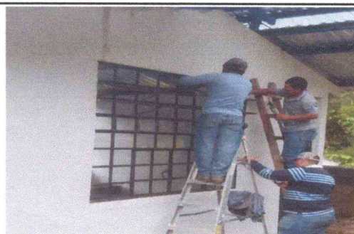
Foto 6: MOMENTO EN SE RETIRARON LOS VIDRIOS DAÑADOS EN SU TOTALIDAD. EN LAS FOTOGRAFIAS SE MUESTRAN 3 VENTANAS QUE CORRESPONDEN AL RENGLO DE COCINA.
