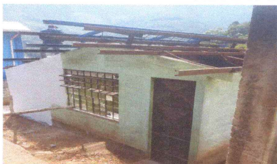
Foto 3: DESENTECHADO DE LA COCINA Y REMOCION DE OXIDO DE VIGAS - COSTANERAS Y LA APLICACIÓN DE ANTICORROSIVO.
